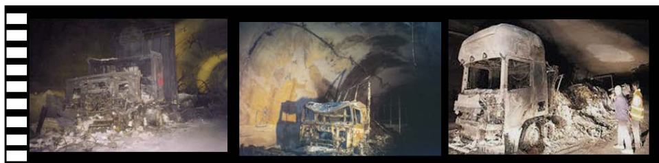
Figura 8. Fotogramma degli effetti dell'incendio.
